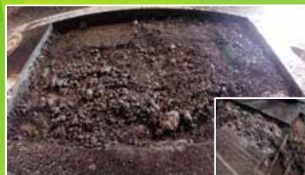
橋梁床版の土砂化状況
