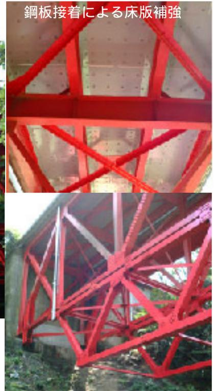
鋼板接着による床版補強
