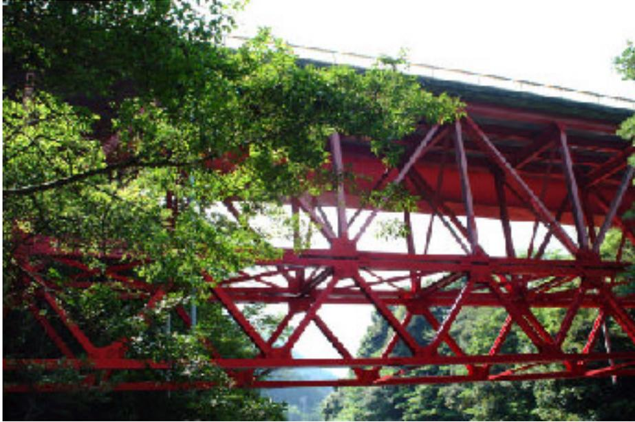
トラス追加による主桁補強
